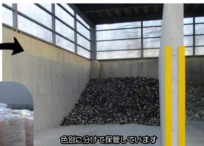
完成したストックヤード
