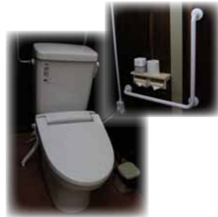
【簡易水洗化工事を行ったトイレ】
