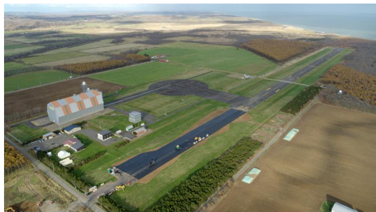
滑走路延伸工事の様子
