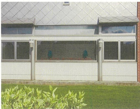
【分館外観・底部】
