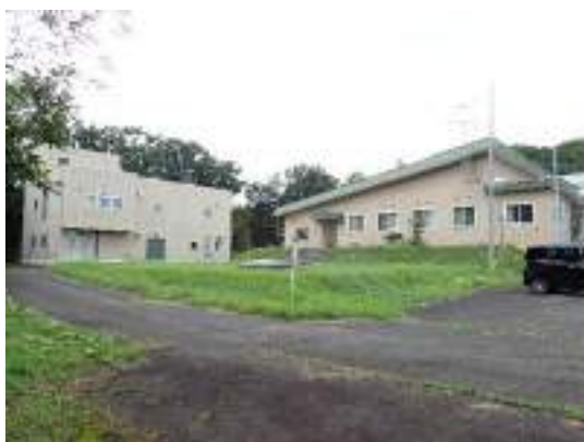
坂下配水池（既設）
