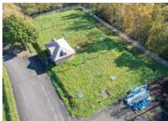
坂下配水池（増設）
