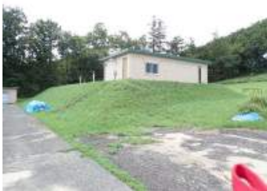
着水井・普通沈殿池
