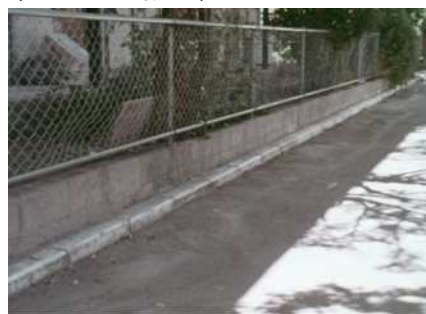
（下水道整備後）
