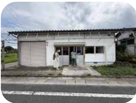
▲空き家を改修して開店した本屋さん
