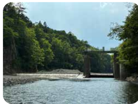
▲更新が必要と判断された坂下水源系の取水施設
