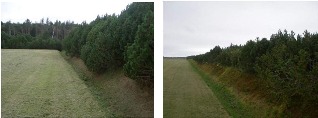
図-3.9 滑走路地区外周の素掘り側溝（2017年9月23日撮影）
