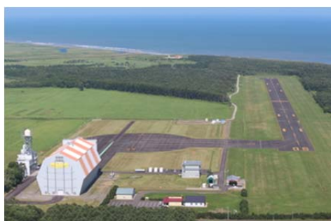
図-1.1.1 大樹町多目的航空公園全景
