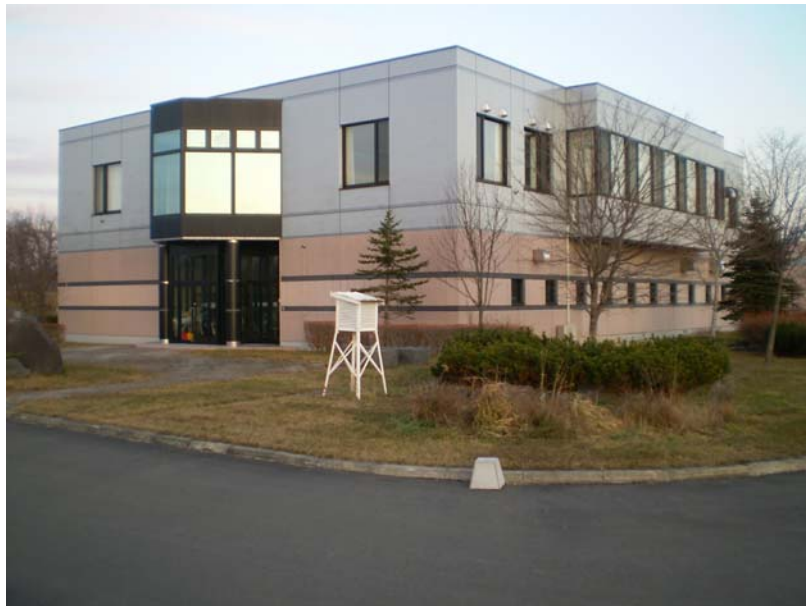
大樹下水終末処理場 管理棟
