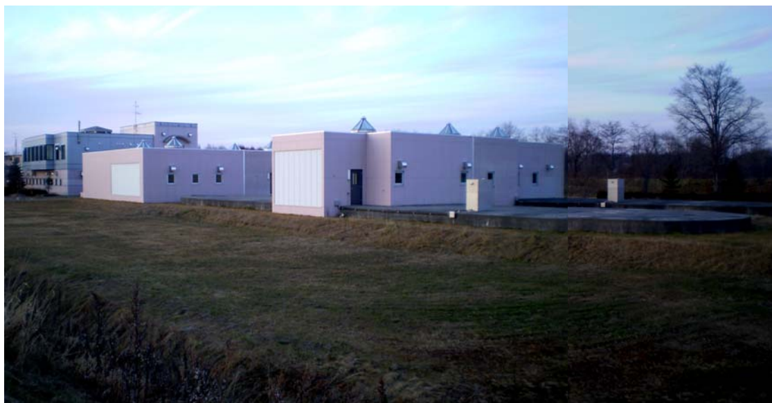
大樹下水終末処理場 水処理施設全景
