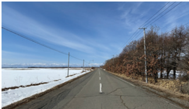
避難路となっている町道浜大樹線
