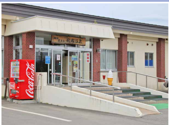
小破修繕で維持している晩成温泉
