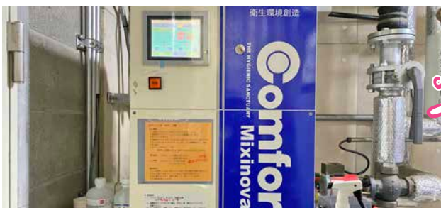
衛生殺菌消臭水生成装置設置工事（349万円） 汎用性の高い次亜塩素酸水を生成できる装置を更新
