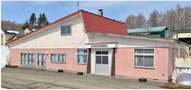
晩成行政区会館改築工事（6,000万円） 老朽化している行政区会館を計画的に整備
