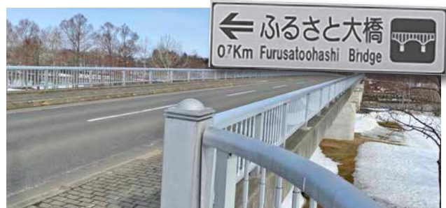
ふるさと大橋補修工事（7,000万円） 平成9年12月に完成した、ふるさと大橋を補修
