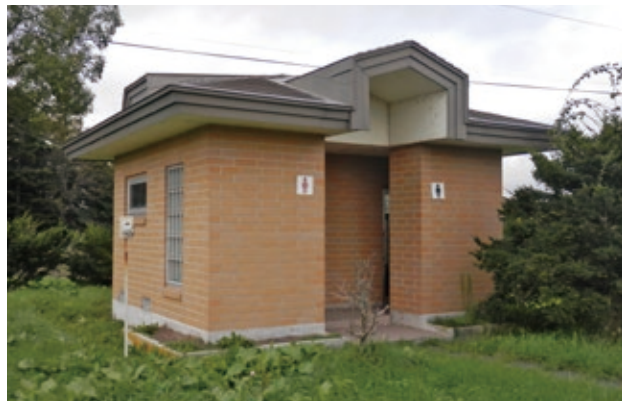
町が管理する公衆トイレ
