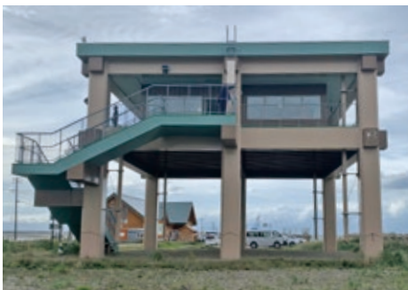
別海町野村半島に整備された津波避難施設
